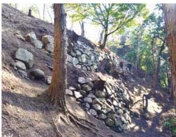
石垣 6・7 北西から
