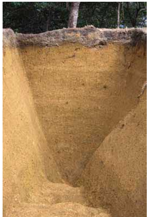
曲輪 90 17-2トレンチ 曲輪を造成する盛土
