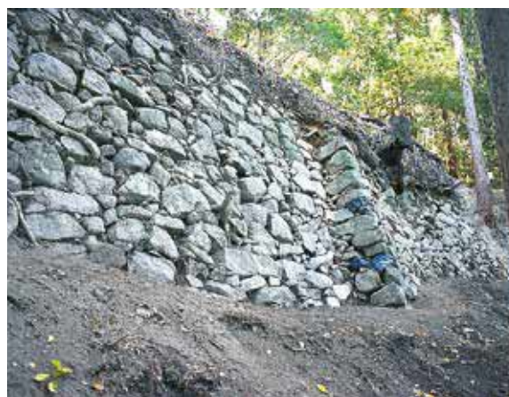
出角のある石垣 (石垣 69)
