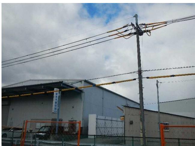
【写真3】 電線防護の状況
