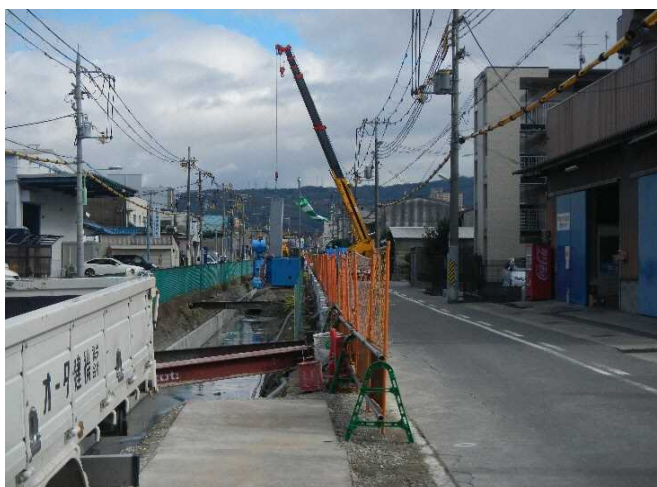
【写真1】 コンクリート矢板吊り込み状況（始点側から望む）
