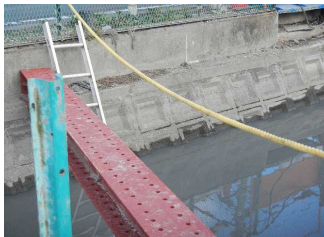
【写真6】 水路を横断して仮置きされている鋼製山留財
