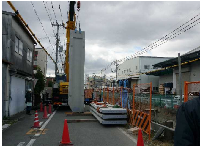
【写真4】 コンクリート矢板吊り込み状況（近景）
