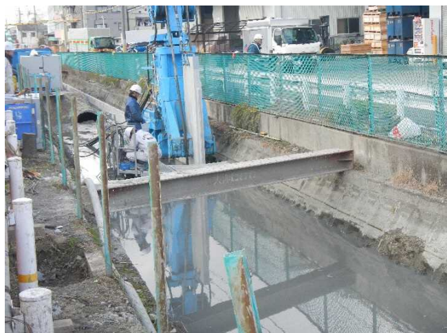
【写真2】 コンクリート矢板圧入状況（近景）
