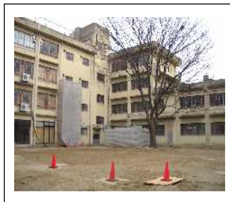
写真2 中庭（浄化槽、受水槽が撤去されている）
