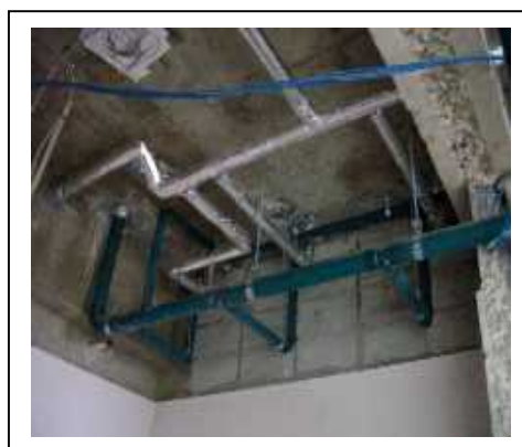
写真4 トイレ改修（天井の設備配管の設置）
