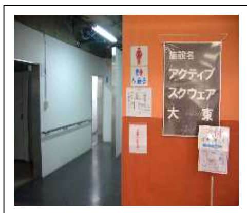
写真5 1階トイレ入口（既改修済、使用中）
