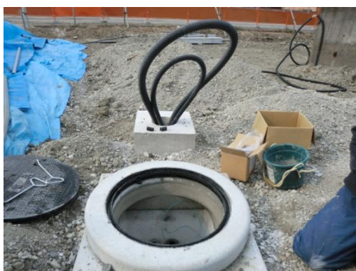
⑤照明柱基礎とハンドホールの状況
