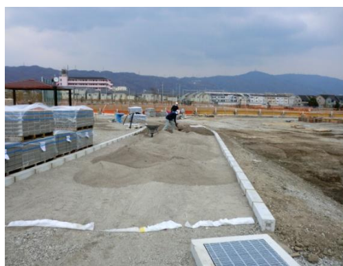
⑥園路施工状況
