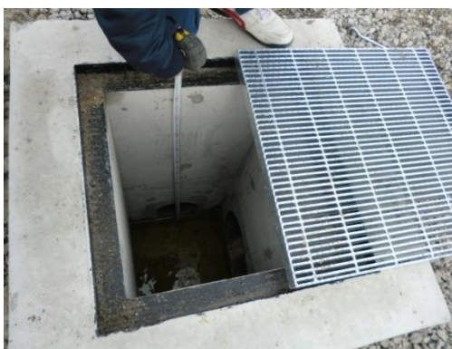
④排水会所の状況
