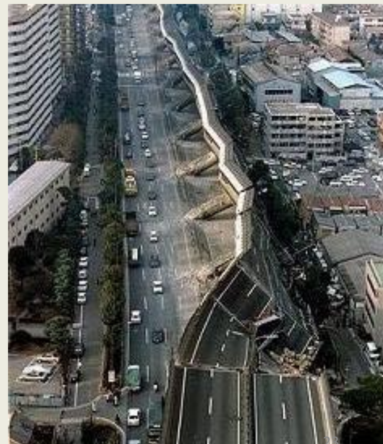
高速道路の倒壊(阪神淡路大震災:神戸・芦屋市)震度7
