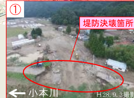
堤防決壊状況
