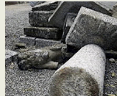
神社灯籠の倒壊(三重県中部地震)震度5強
