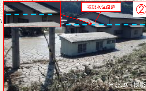
浸水解消後の流入土砂堆積状況
