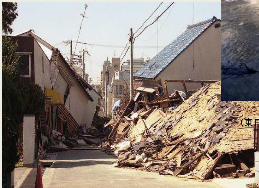
住宅倒壊による道路閉塞(阪神淡路大震災)震度6強
