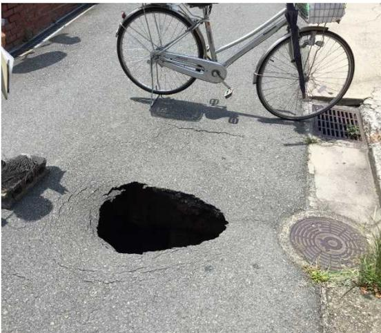
国土交通省によると、平成 27 年には下水道管が原因となった陥没事故が全国で約 3,300 件起きています。今後は、どのような場所で陥没が起きやすいのかを分析して、効率的な対策をとることが必要です。大東市では随時、地下の空洞調査に取り組んでいます。
