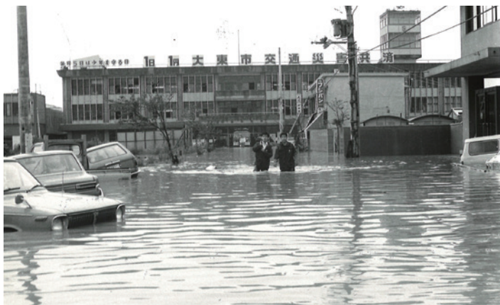
昭和47年7月豪雨時の市役所前
