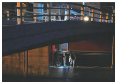
▲橋の下もしっかり点検
