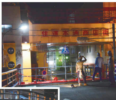
▲可動式で橋ごと堤防の 高さまで上がります
