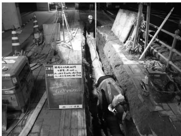
諸福中垣内線配水管布設替工事 （H29－1）
