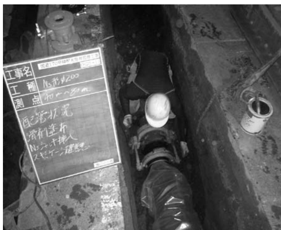
国道170号線配水管布設替工事（H26－1）
