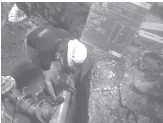
八尾枚方線配水管布設替工事 三箇二丁目地内 G X形耐震管 \phi 150\text{mm}
