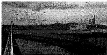
西側から見た戎大黒橋
