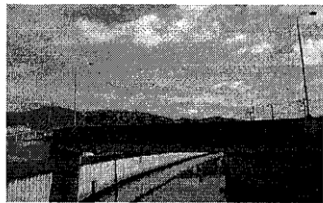
北西方向から見た御供田新橋
