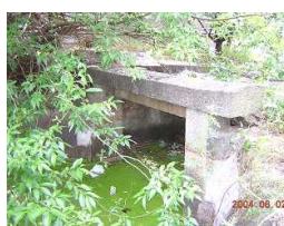
かみなり樋門
