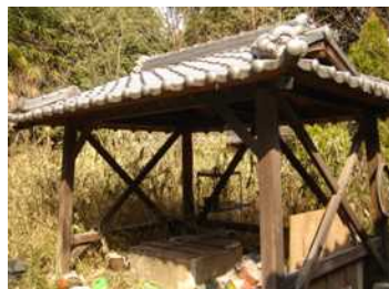
井戸と覆屋（南西から）
