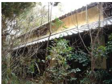
主屋棟（南東から）
