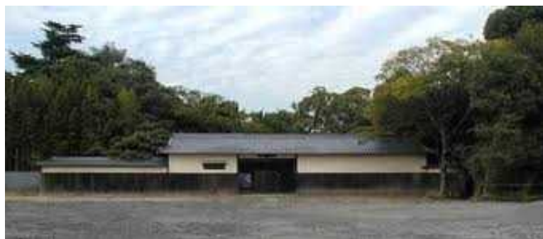
解体前の（表）長屋門
