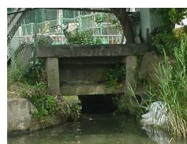
谷川1丁目の樋門
