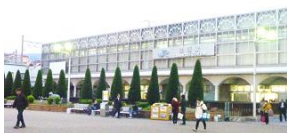
住道駅北デッキ
