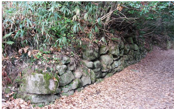
石垣（写真は高櫓郭東側）
