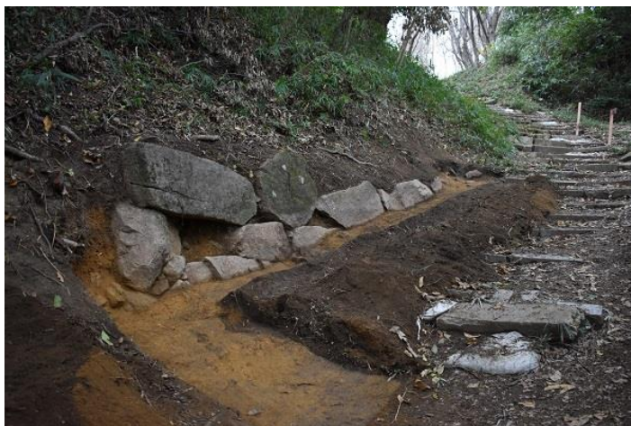
虎口の西側（南丸斜面裾）に 築かれた石垣
