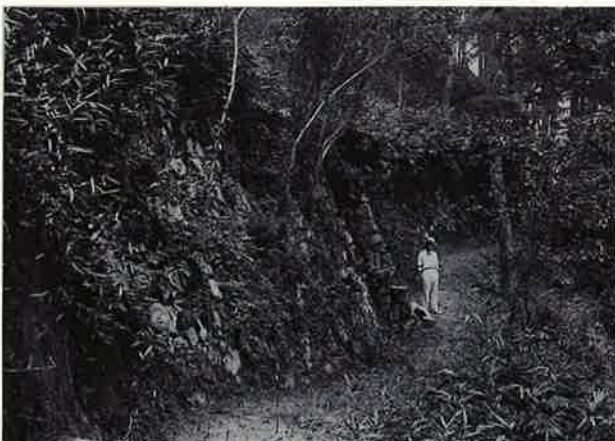
図9 古写真(本郭II 東側石垣) 大阪府教育委員会提供
