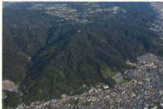
図2 飯盛山遠景（北西より）
