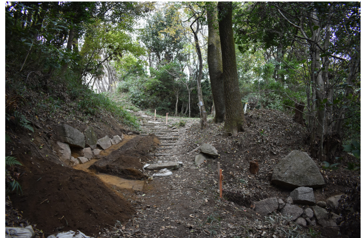
「南丸」の斜面裾（左側）と東側の曲輪の斜面（右側）に石垣を築いています。 「千畳敷曲輪」へ続く通路は西に少しカーブしており、虎口から曲輪の入口を直接見通すことができないように工夫されています。両側の曲輪から城内に侵入した敵を攻撃できる構造であったと推定されます。
