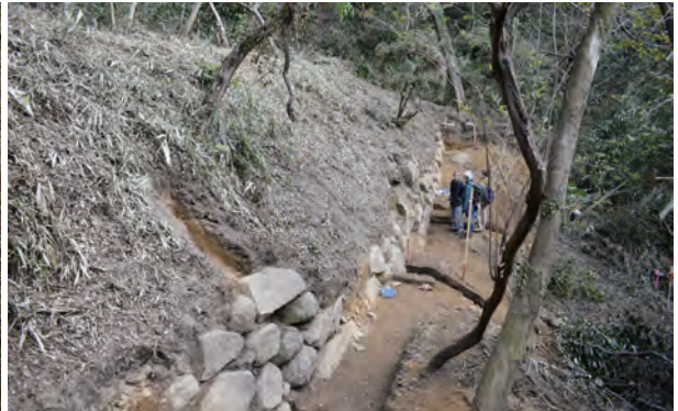
図 2-4 石垣の積み方・構造などの検討
