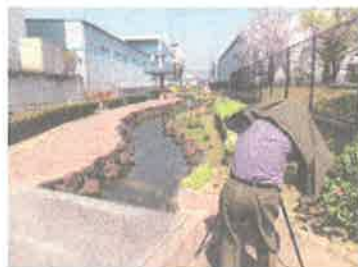
12 号水路と撮影の様子
