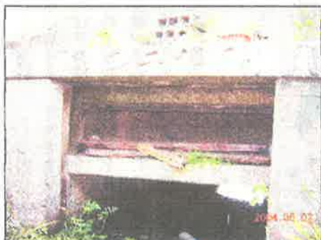
④ 三反物の樋 (弘化2年 1845) 新田の要にあたる地点の樋門。現在はシー トで覆われている。
