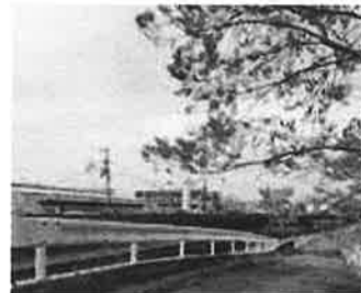
寝屋川越流堤
