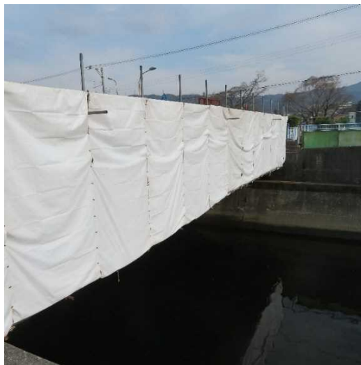
写真2 全景（下流右岸から：防護シート設置）
