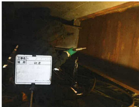
写真4 主桁塗装剥離施工状況
