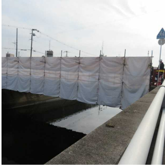
写真1 全景（上流右岸から：防護シート設置）
