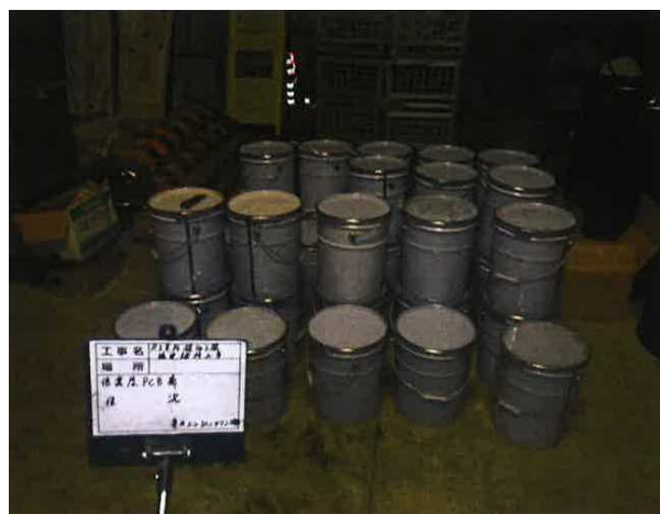
写真5 特別管理産業廃棄物(低濃度PCB廃棄物)の処理後の保管状況
