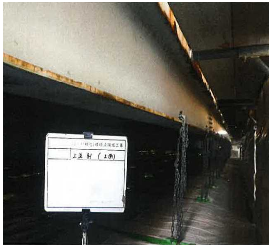
写真3 主桁下足場設置状況
