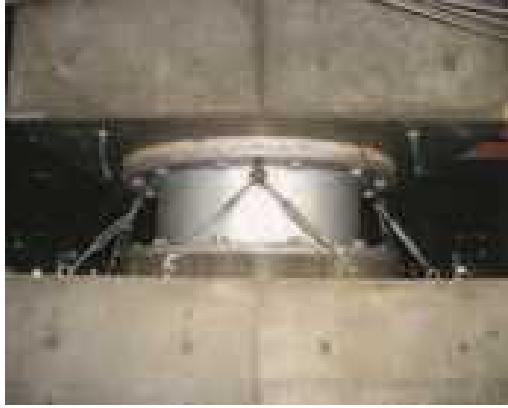
地震時の建物の揺れ 자체を大幅に低減する免震構造を採用している。免震層は地下駐車場を利用した柱頭免震としており、免震層を無駄なく有効利用しています。
