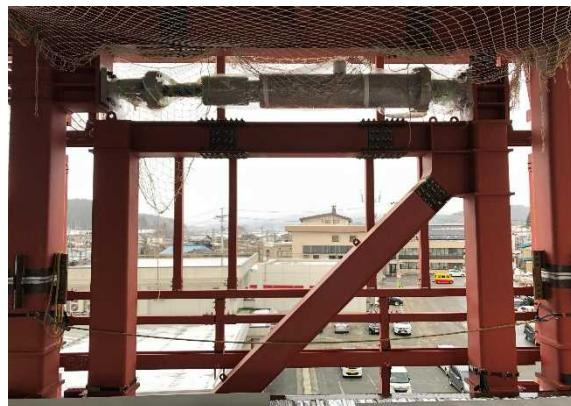
制振ダンパーを主体構造と切り離した耐震壁頂部（屋根下部）に配置し、本体屋根と制振ダンパーで接続することで、少ない制振ダンパー数で効率のよい制振構造としています。
