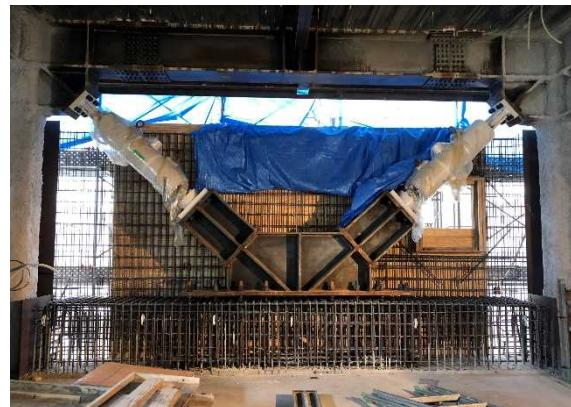
鉄骨造制振構造としているが、制振ダンパーは1階のみに配置するソフトファーストストアリ-制振とすることで少ない制振ダンパー数で費用対効果の高い制振構造としています。
