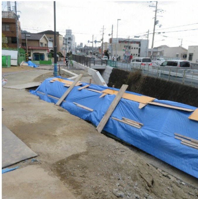
写真 4 鎌池公園芝生地盤高さから親水広場を望む (工事シートの先が親水広場)
