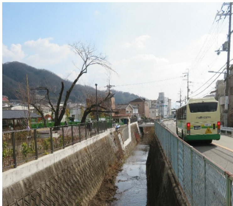
写真1 全景（上流右岸から：親水広場工事区間）
