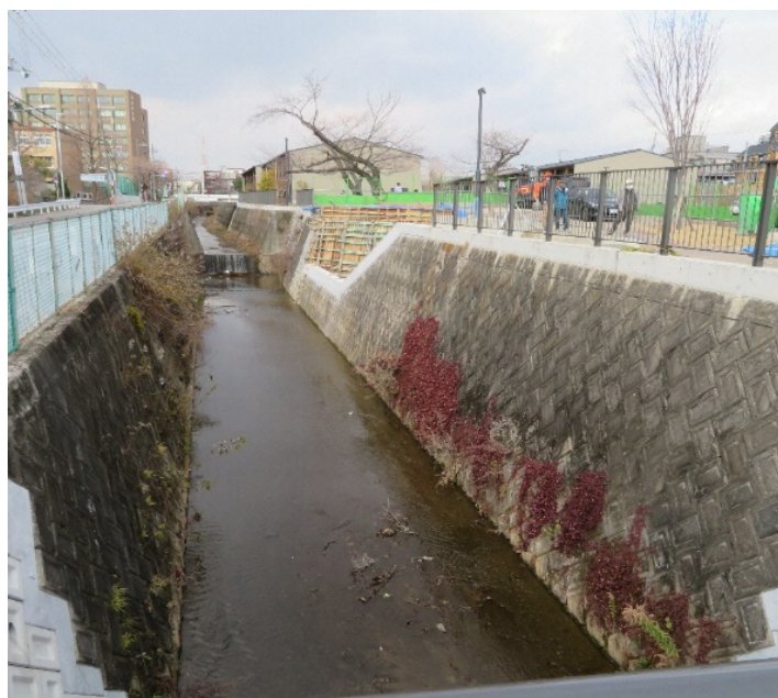
写真2 全景（下流右岸から：親水広場工事区間）
