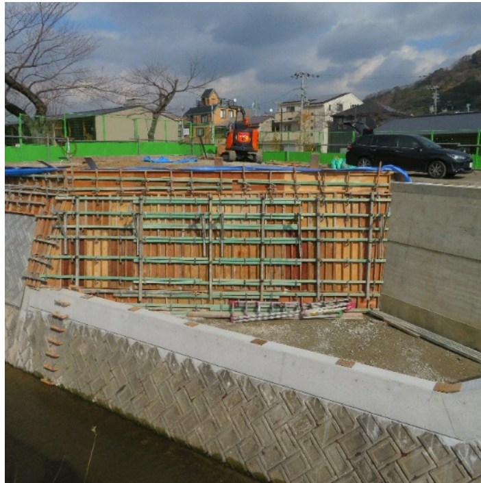
写真 3 親水広場擁壁工
