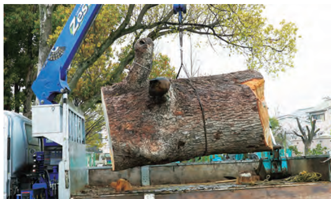
▲クレーン車を使った移設作業
