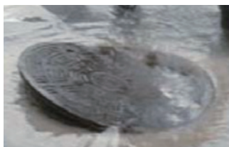
浮き上がってずれたマンホールのふた 浮上防止ロック機能付きマンホール
