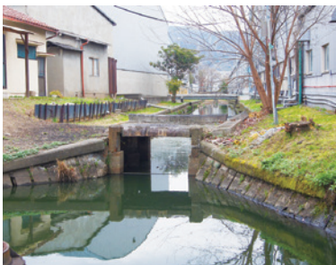
幕末につくられた「かみなり樋門」
