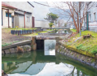
幕末につくられた「かみなり樋門」
