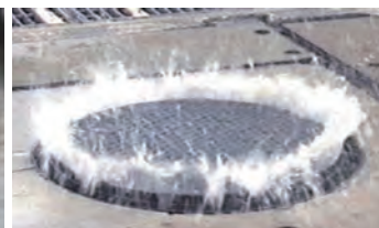
浮き上がってずれたマンホールのふた 浮上防止ロック機能付きマンホール
