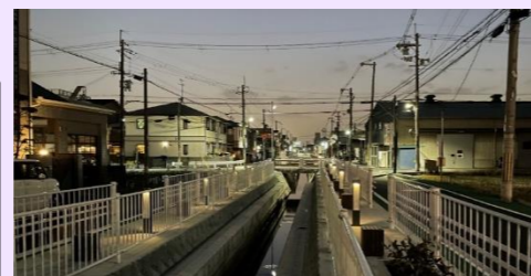
親水機能を持った水路整備（新田水路）↑
