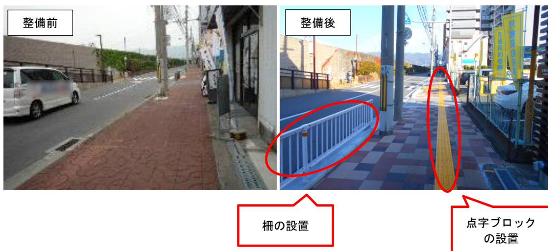
歩道のバリアフリー化の取組事例（住道駅前西線の例）
