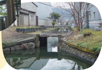
かみなり樋門
