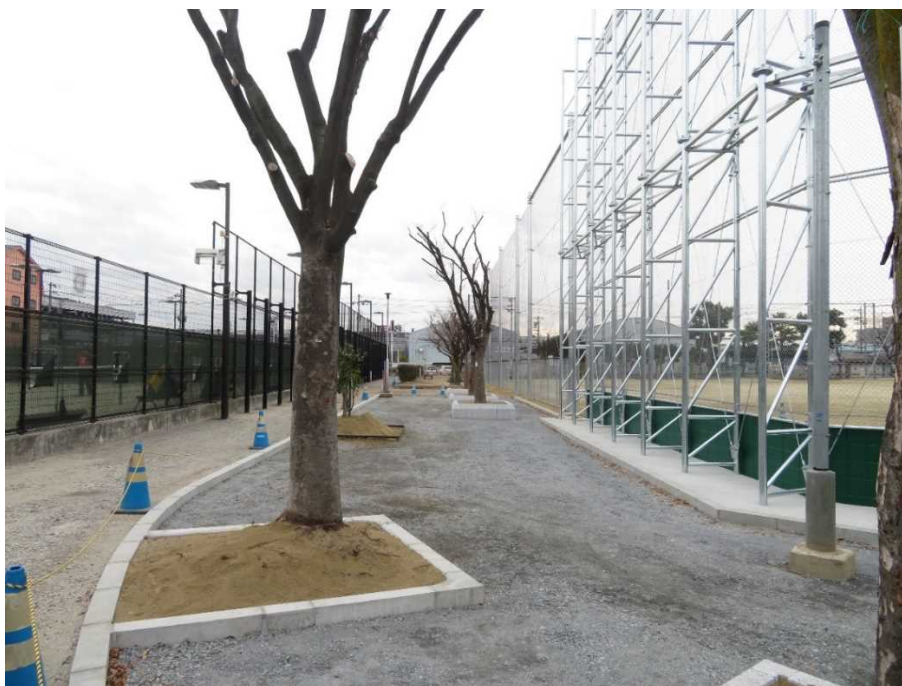
写真1 バックネット支柱及び植栽（根上がり防止）
