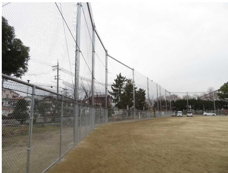
写真2 金網フェンス・エコネット設置
