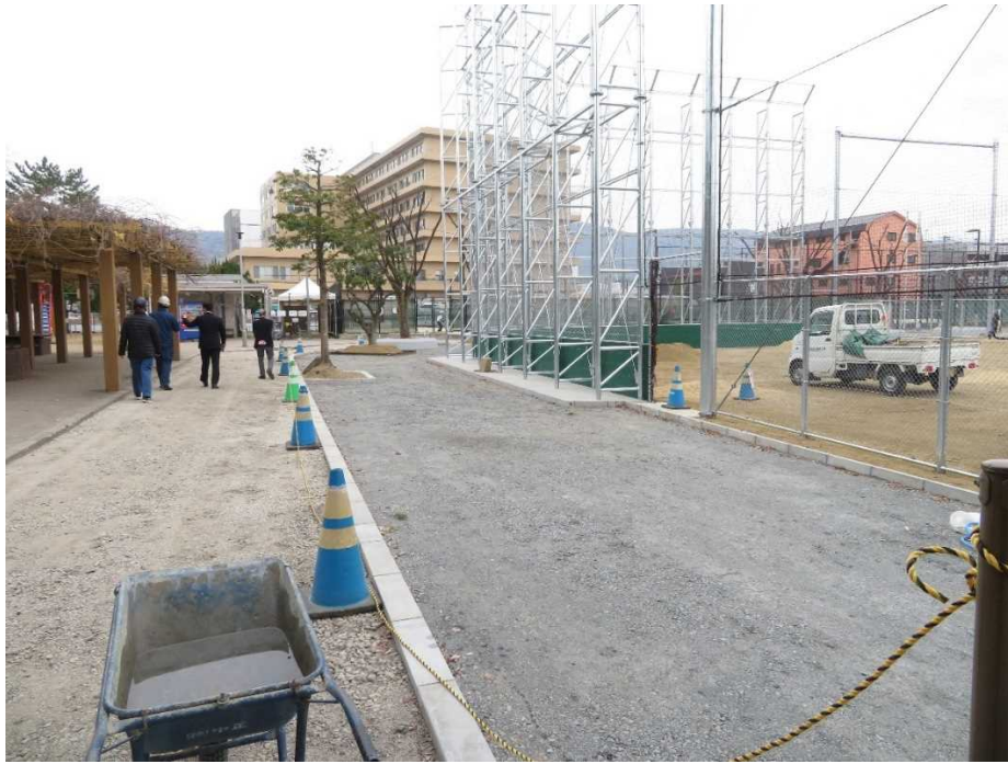
写真3 新設バックネット（防球フェンス）
