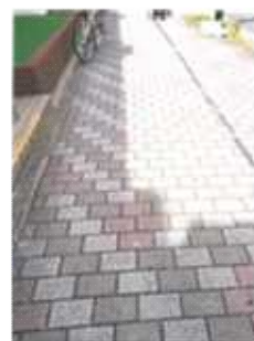
府・野崎停車場線： 視覚障害者誘導用ブロックの設置
