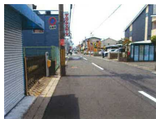
府・鴻池新田停車場線：歩道の設置
