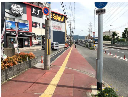
●視覚障害者誘導用ブロックの設置
