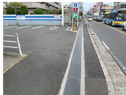
●グレーチングの改善
