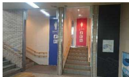
●一般トイレ入り口両側手すり設置
