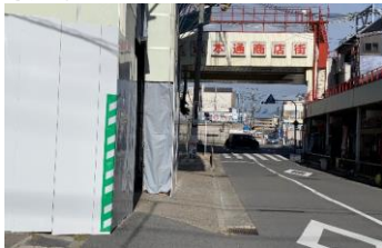
歩道の改良(横断勾配の改善)
