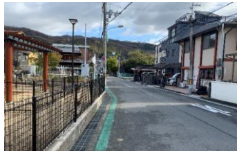
グレーチングの改善
