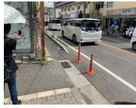
グレーチングの改善
