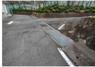
グレーチングの改善
