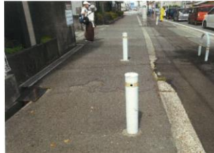
障害物の撤去
