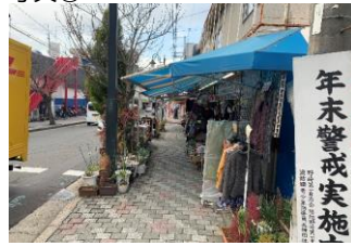
視覚障害者誘導用ブロックの設置 (無電柱化含む)
