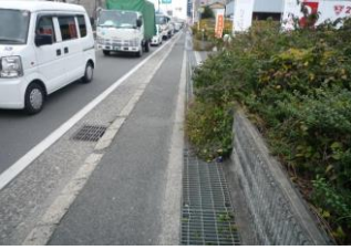
グレーチング改善
