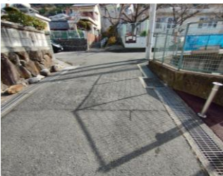
グレーチングの改善
