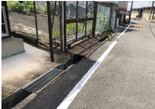
グレーチングの改善
