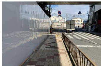
視覚障害者誘導用ブロックの設置
