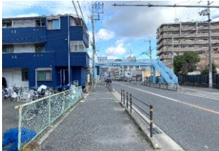
視覚障害者誘導用ブロックの設置
