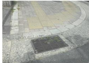
グレーチングの改善
