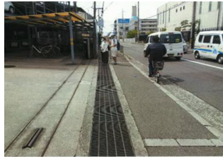
グレーチングの改善
