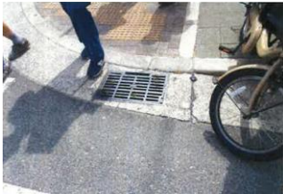
グレーチングの改善
