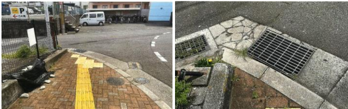
グレーチングの改善
