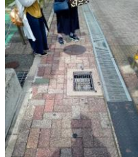
グレーチングの改善
