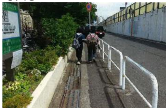
グレーチングの改善
