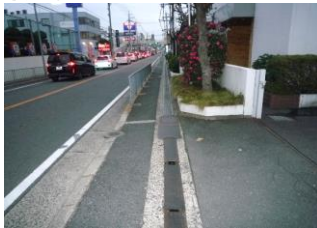
グレーチング改善
