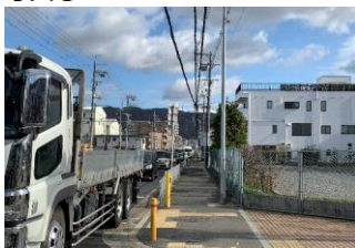
視覚障害者誘導用ブロックの設置（南側）
