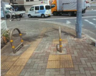
歩道上障害物（バリカー等）の撤去等
