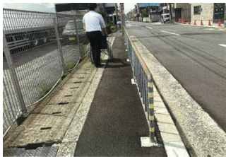
歩道の整備（東側）
