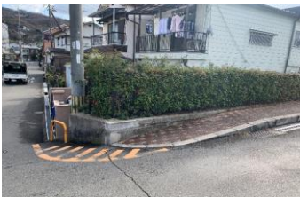
歩道の改良（縦断勾配の改善）
