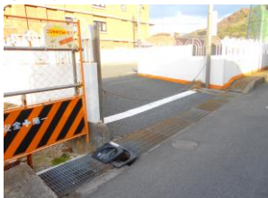
グレーチングの改善
