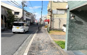
歩道の改良（横断勾配の改善）
