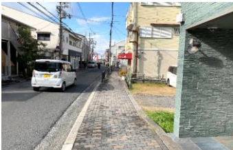
歩道の改良（横断勾配の改善）
