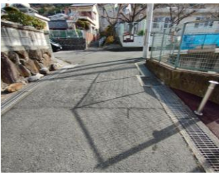
グレーチングの改善
