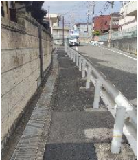
グレーチングの改善
