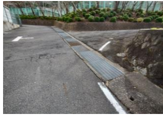
グレーチングの改善
