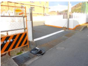
グレーチングの改善
