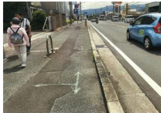
障害物の撤去
