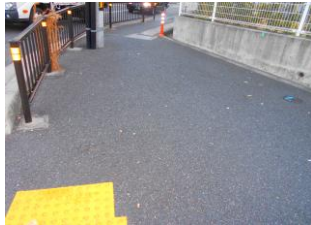
歩道の改良（横断勾配の改善）
