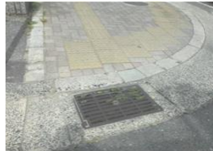
グレーチングの改善
