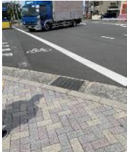
グレーチングの改善
