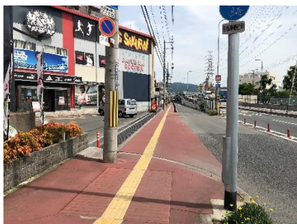
●視覚障害者誘導用ブロックの設置
