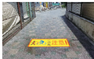
路面標示の新設
