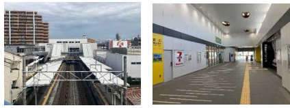
基幹事業:地域生活基盤施設 野崎駅自由通路
