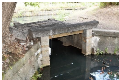
図 49 樋門と水路等（かみなり樋門）
