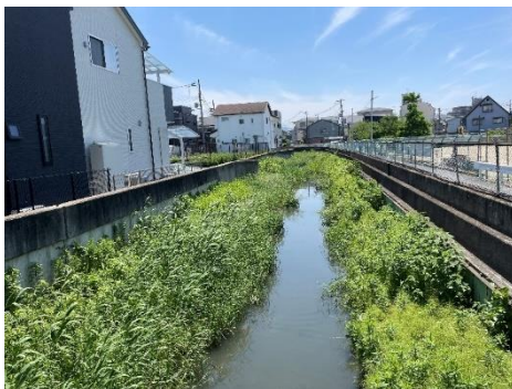
図 48 樋門と水路等（銭屋川）
