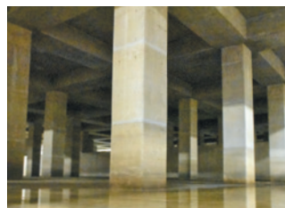
▲ 南郷公園の地下調節池
