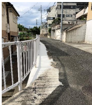
安全柵の新設
