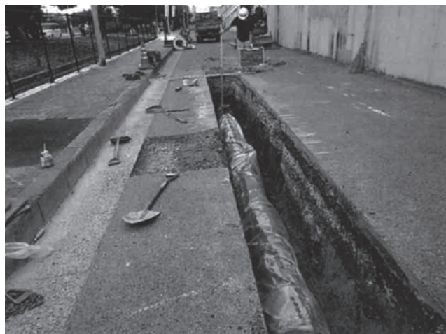
諸福中垣内線配水管布設替工事 (R5-1) 諸福一丁目地内 G X形耐震管 \phi 300\text{mm}
