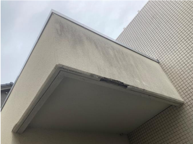
建物等の老朽状況（コンクリート剥離）
