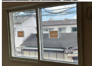
主居室の南側に内窓設置
