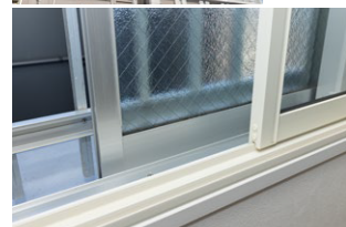
全住戸の内窓設置を実施
